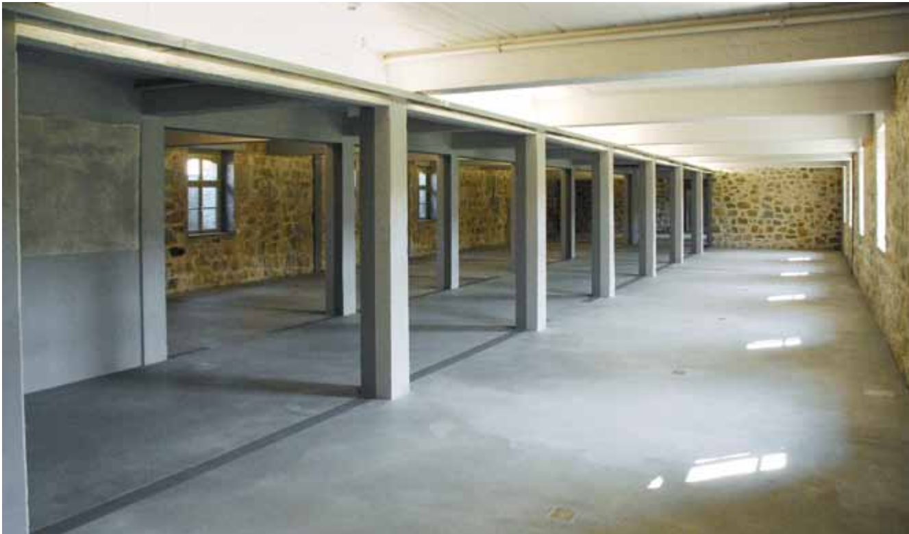
Bereich der zukünftigen Ausstellung „Tatort Mauthausen: Eine Spurensuche“ nach der Sanierung; die grauen Streifen, die am Fußboden zu sehen sind, zeigen die historischen Wandstellungen (© Bundesministerium für Inneres/Stephan Matyus).
