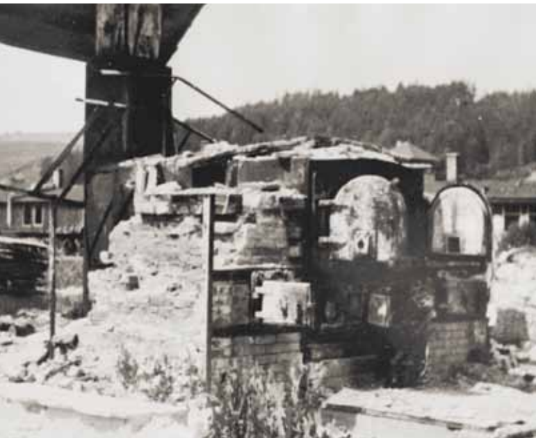
Die Ofenanlage vor dem Beginn der Sanierung, etwa 1949 (Ministère de la Défense – Direction de la mémoire, du patrimoine et des archives, Paris).
