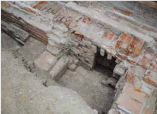
Das Fundament der Trennwand des Kokslagers (oben links bis unten rechts) überquert einen „Kanal“, der sich unter dem südlichen Koksofen befindet (Foto: Roman Igl).
